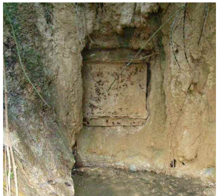
Porte de la caverne-réservoir en 2008, avant travaux
