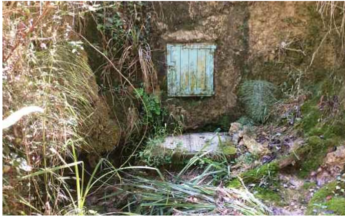
Porte de la caverne-réservoir de grande capacité
